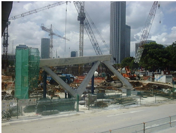
写 - 1 MockUp 完成状況
