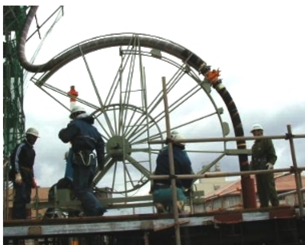
写真-2 エスカル打設状況
