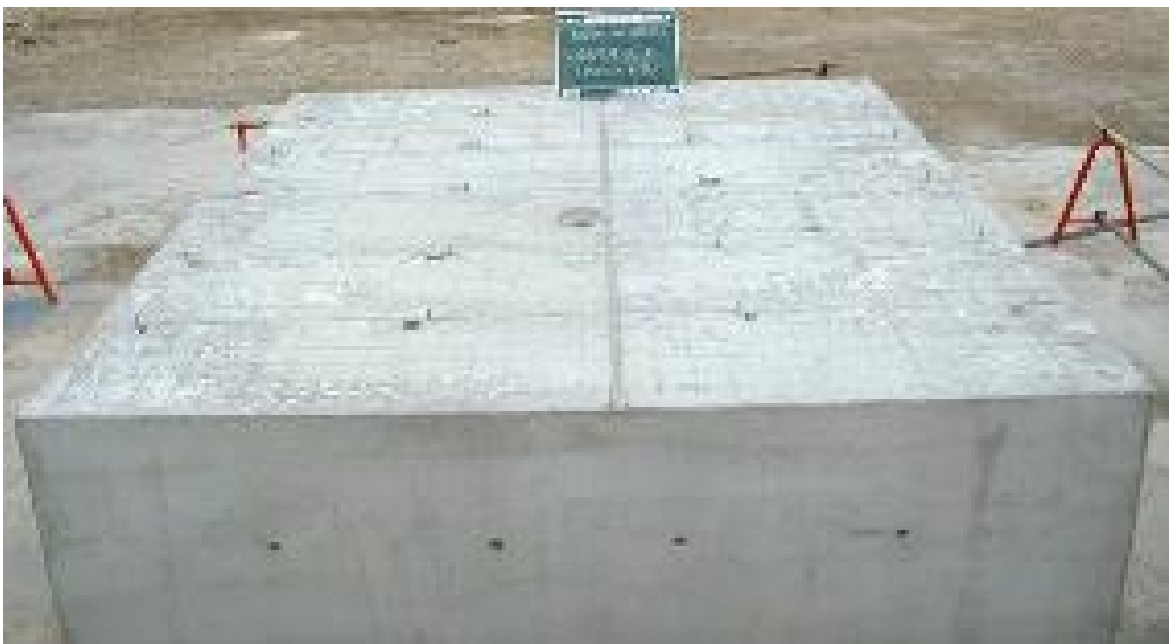
写真 - 4 試験施工充填状況（朝日コン工業）
