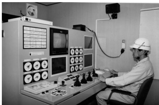
写真-2 操作室外観
