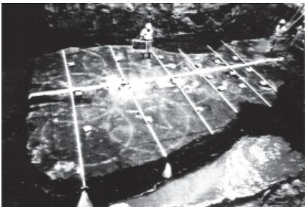
写真-2 掘削による改良土の出来形確認
