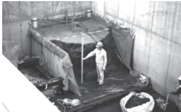
写真 - 1 土槽解体時の固化体出来形
