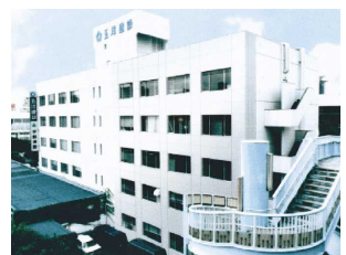
写真-5 施工後合成写真
