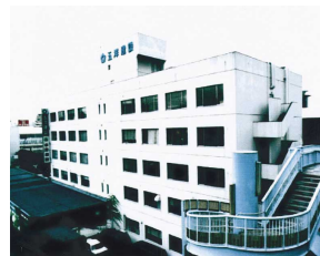
写真-4 施工前外観
