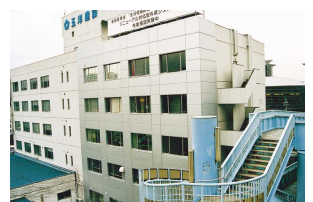
写真-7 施工後外観
