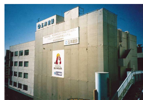
写真-6 施工中外観
