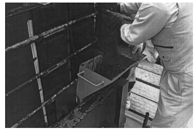
図 - 10 使用ホッパ 写真 - 2 外殻体打設状況
