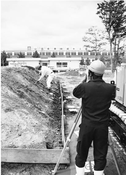
写真-3 トータルステーションによる計測状況
