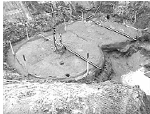
写真-1 改良体形状（新潟実証実験）
