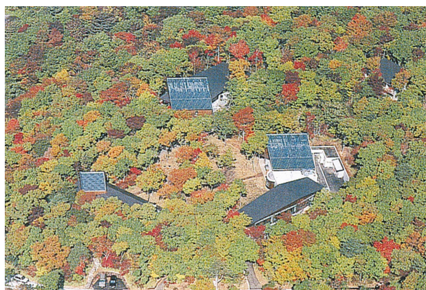
写真 - 2 各棟の集熱屋根・太陽電池モジュール
