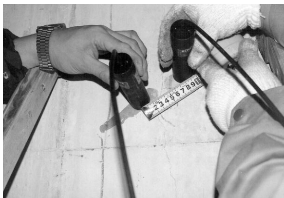
写真 - 4 ひび割れ深さ測定状況
