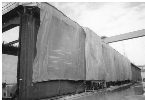
写真 - 3 日除けシート敷設および散水養生状況
