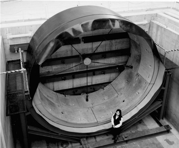
写真 - 7 組立完成
