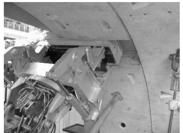
写真-6 Kセグメント挿入状況
