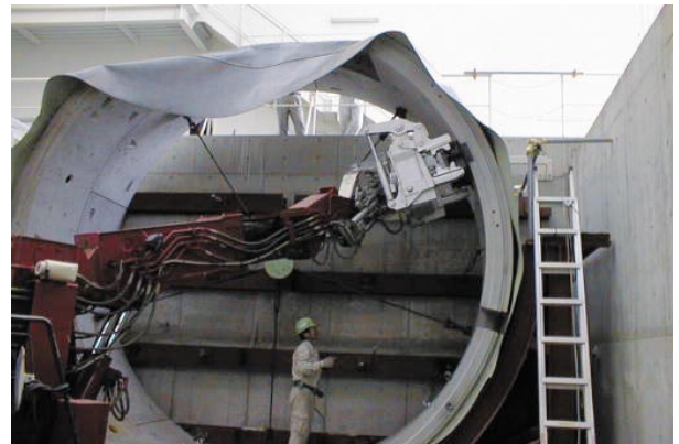
写真-4 セグメント組立状況
