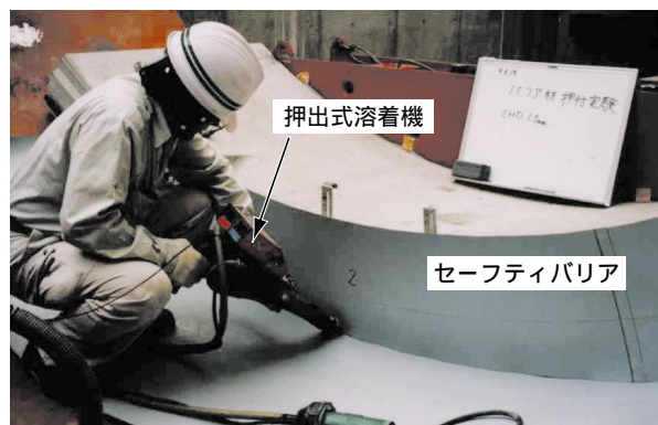
写真 - 1 セーフティバリア溶着状況
