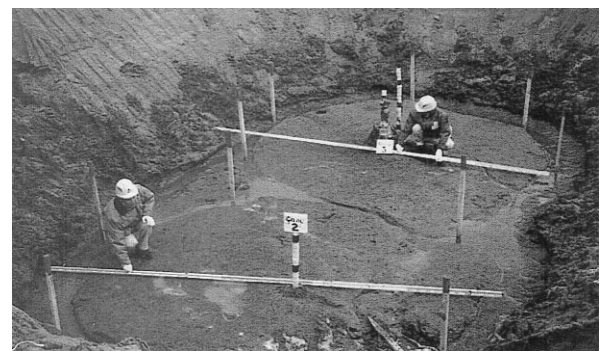
写真 - 1 超微粒子シリカによる改良土の掘削状況
