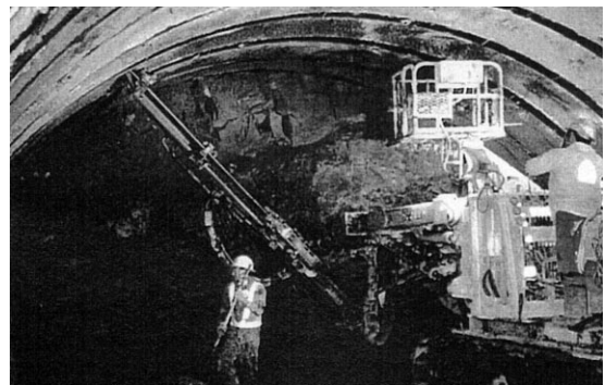
写真-1 ロックボルト施工状況
