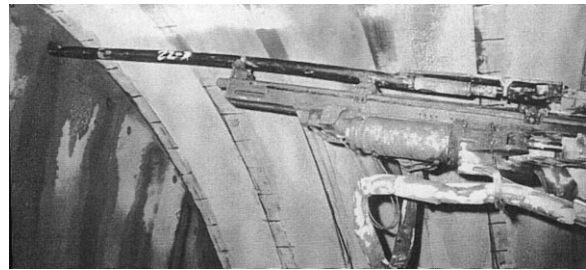
写真 - 7 曲がりAGF鋼管打設状況
