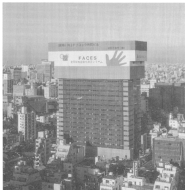
写真-5 外壁パネル取付け後の建物の外観
