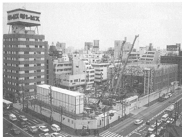
写真-2 リフトアップフレーム組立状況
