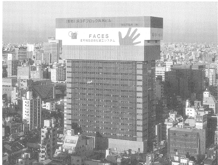
写真-1 システム全景
