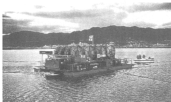
写真-1 ドレーン埋設台船
