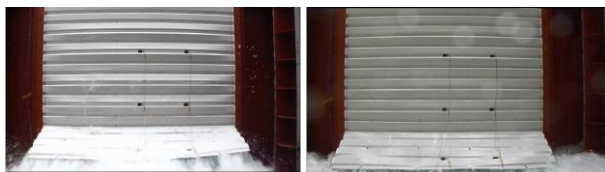
(a) 破壊時 (b) 破壊直後 写真-8 破壊時以降の状況(横張・負圧)
