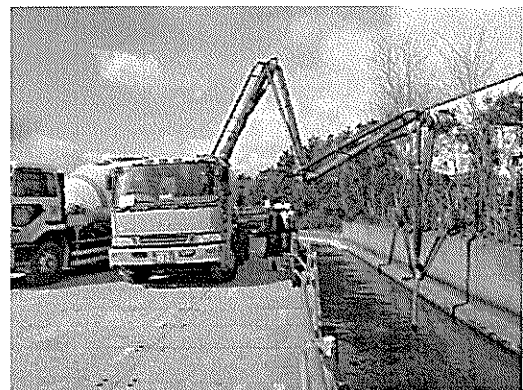
写真-2 施工状況
