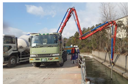
写真-2 施工状況
