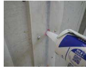
写真-2 シリコーンゴム (t=2mm) と注入孔
