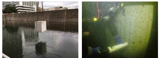
写真-3 京浜港ドック施工状況
