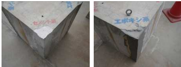
セメント系 エポキシ系 写真-4 角欠け部型枠脱型後
