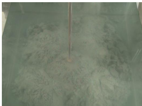
写真-2 処理土B打設直後
