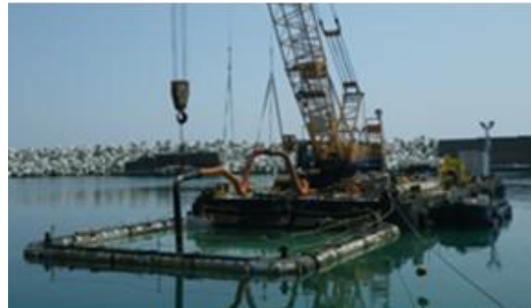
写真-5 処理土による覆土の作業全景
